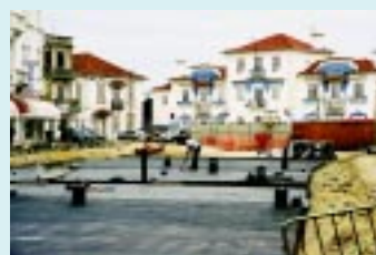
Modernização da Linha do Norte-Refer Estação de Aveiro
