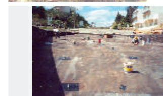
Vista Geral - Tratamento Individual
