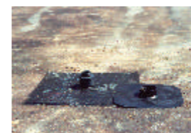
Pormenor do atravessamento
