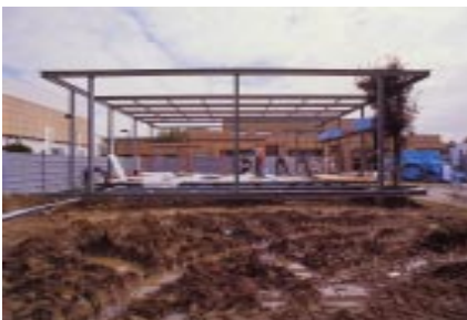
Aplicação de Isolamento Térmico DOW
