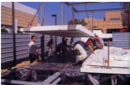
Aplicação de Membranas Imperialum
